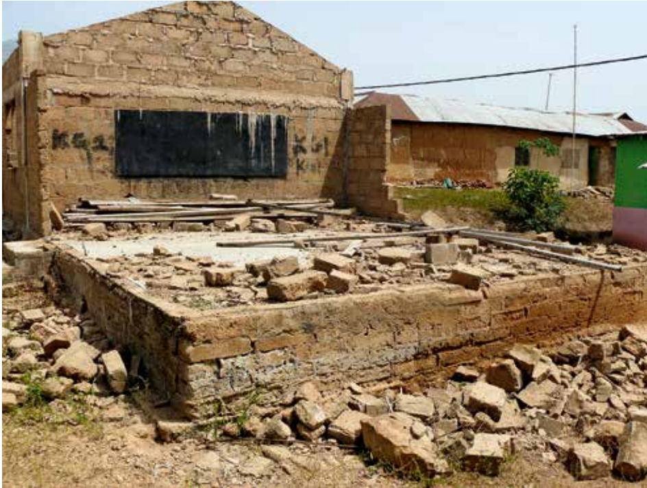
Der Klimawandel verursacht in Afrika unter anderem schwere Unwetter: hier ein zerstörter Kindergarten in Ghana. Foto: W. Blum
